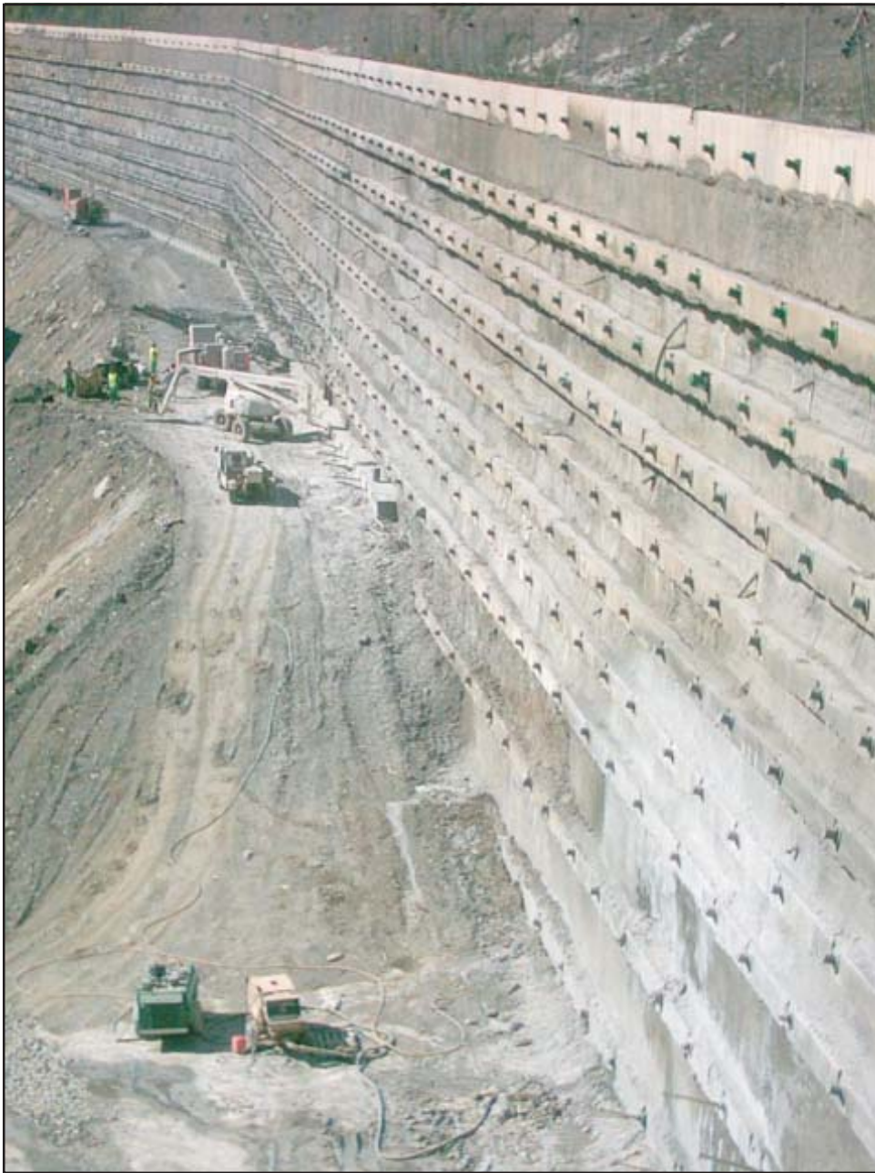
AQUEST ÉS EL MUR DE CONTENCIÓ DE LA VALL DE RUDA, QUE PROTEGIRÀ LA ZONA HOTELERA I QUE FA 400 METRES DE LLARGADA I UNS 40 D'ALÇADA
